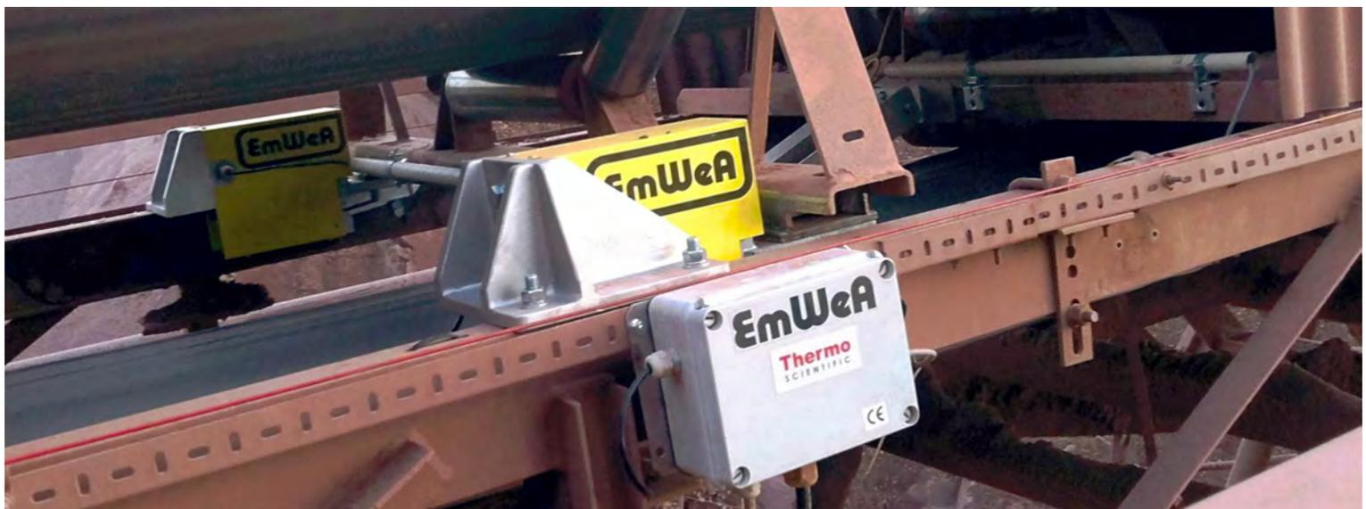
Die Bandwaage IDEA besteht aus der modular aufgebauten Wägemechanik IDEA und dem Geschwindigkeitsgeber ZA-11. Es werden außerdem die leistungsstarken, vielseitigen und modernen Auswerteelektroniken (Integrierer) der Serie MINI CK eingesetzt.
